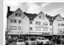
Hofstraße, Essen Ärzte-/Geschäftshaus ca. 2.266 m 2 Mietfläche Vermietungsstand 93% Multi Tenant WALT > 2 Jahre Käufer: Family Office
